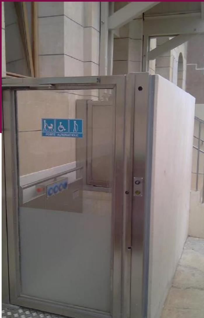
Nos élévateurs PMR sont réalisés pour effectuer des changements de niveau jusqu'à 1,4 mètre en gaine fixe, en intérieur ou extérieur, pour de nouveaux projets ou pour adapter sur des bâtiments existants.
