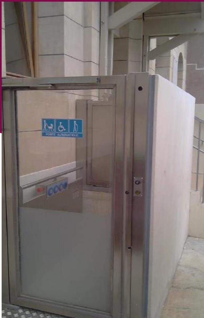
Nos ascenseurs PMR sont réalisés pour effectuer des changements de niveau jusqu'à 1,4 mètre en gaine fixe, en intérieur ou extérieur, pour de nouveaux projets ou pour adapter sur des bâtiments existants.
